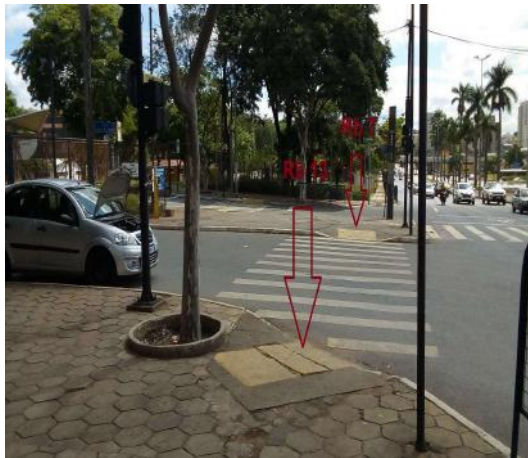
Figura 30: Rebaixos 7 e 13. – Estação UFMG.
