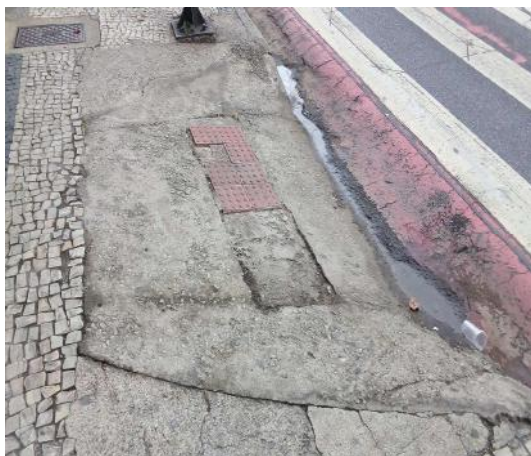
Figura 24: Rebaixo 1. – Estação UFMG.
