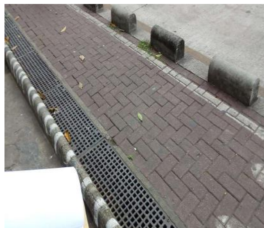
Figura 7: Ciclovia e dispositivo de drenagem. – Estação Carijós.
