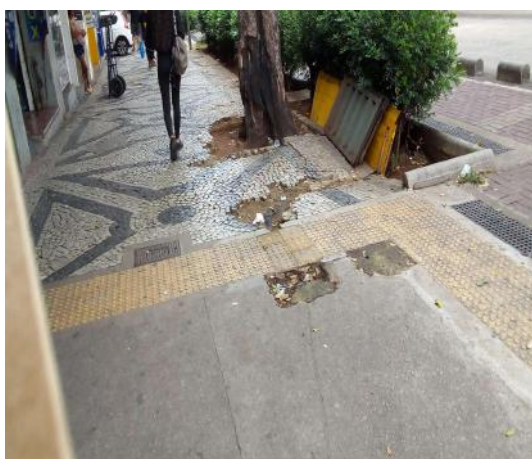
Figura 16: Buracos na calçada do lado dos imóveis de numeração par. – Estação Rio de Janeiro.
