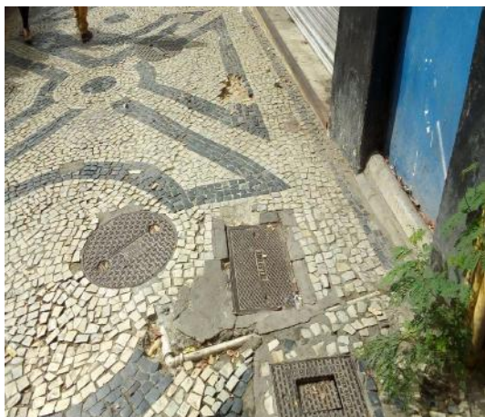
Figura 16: Buracos na calçada do lado dos imóveis de numeração par. – Estação Rio de Janeiro.
