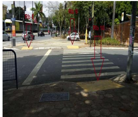
Figura 31: Rebaixos 8, 9 e 10. – Estação UFMG.
