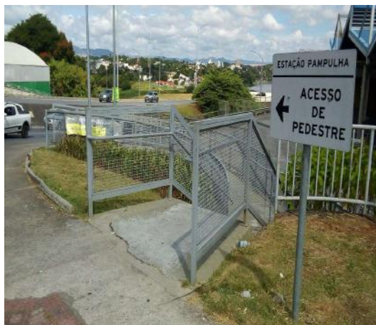
Figura 47: Acesso de pedestres à Estação Pampulha pela Rua Barragem da Pampulha. – Estação Pampulha.
