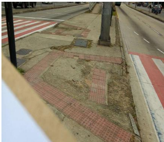
Figura 26: Rebaixo 3. – Estação UFMG.
