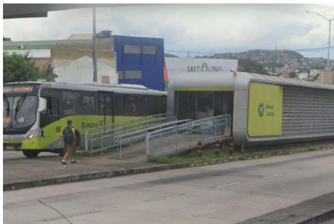
Figura 55: Acesso a estação Monte Castelo – Estação Monte Castelo.
