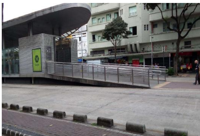
Figura 13: Rampa de acesso à estação. – Estação Carijós.
