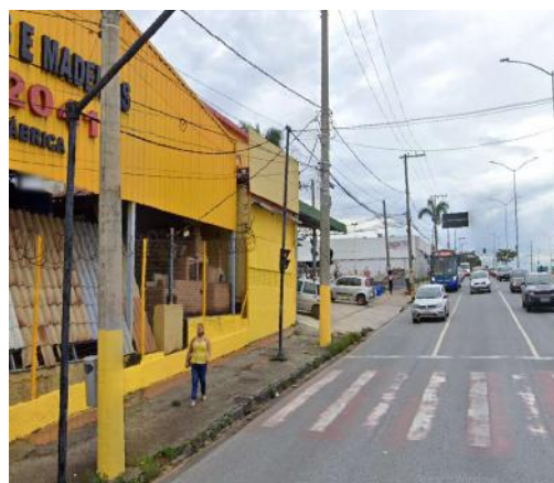
Figura 51: Calçada sem rebaixamento de calçada – Lado dos imóveis com numeração par – Estação Monte Castelo.
