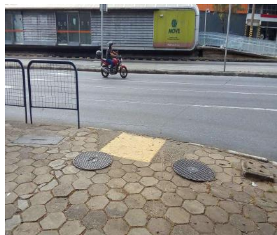
Figura 33: Rebaixo 12. – Estação UFMG.
