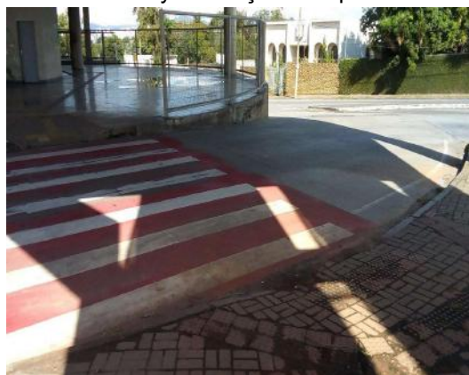
Figura 49: Rebaixamentos de calçadas e faixa de pedestres na área interna da Estação Pampulha – Acesso pela Avenida Portugal e Rua Cheik Nagib Assraury – Estação Pampulha.
