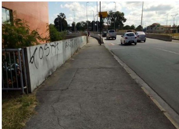
Figura 39: Calçada e viaduto na Avenida Portugal. – Estação Pampulha.
