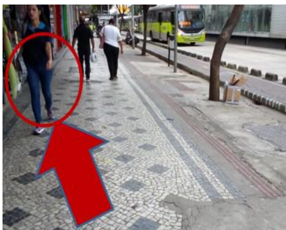
Figura 4: Ondulações na calçada. – Estação Carijós.
