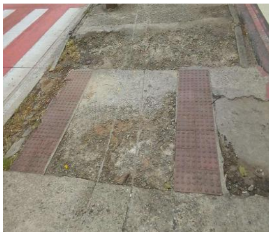
Figura 25: Rebaixo 2. – Estação UFMG.
