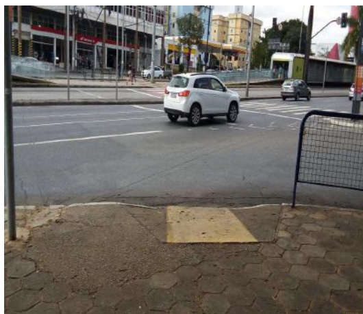
Figura 32: Rebaixo 11. – Estação UFMG.
