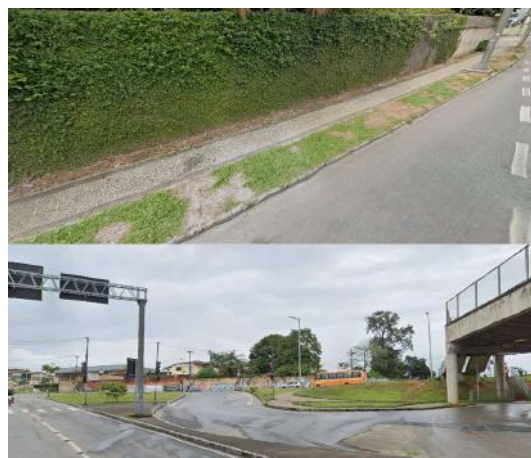
Figura 41: Calçadas nas proximidades do acesso à Estação Pampulha pela Rua Cheik Nagib Assraury. – Estação Pampulha.
