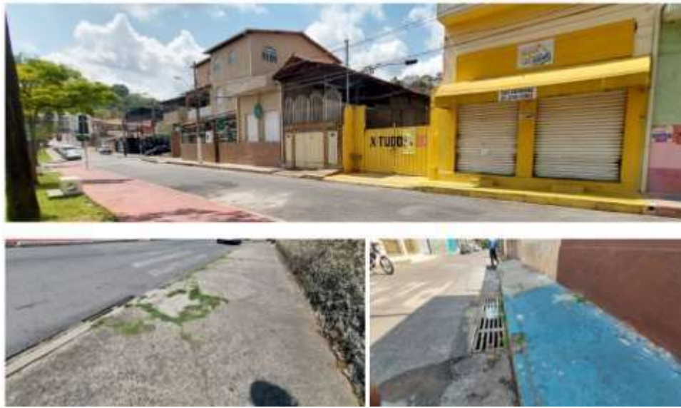
Figura 21: Exemplos de más condições de acessibilidade da calçada
