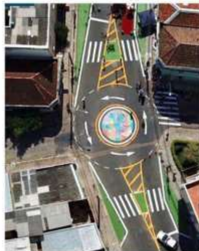
Rua Conselheiro Rocha – Depois da Reforma
