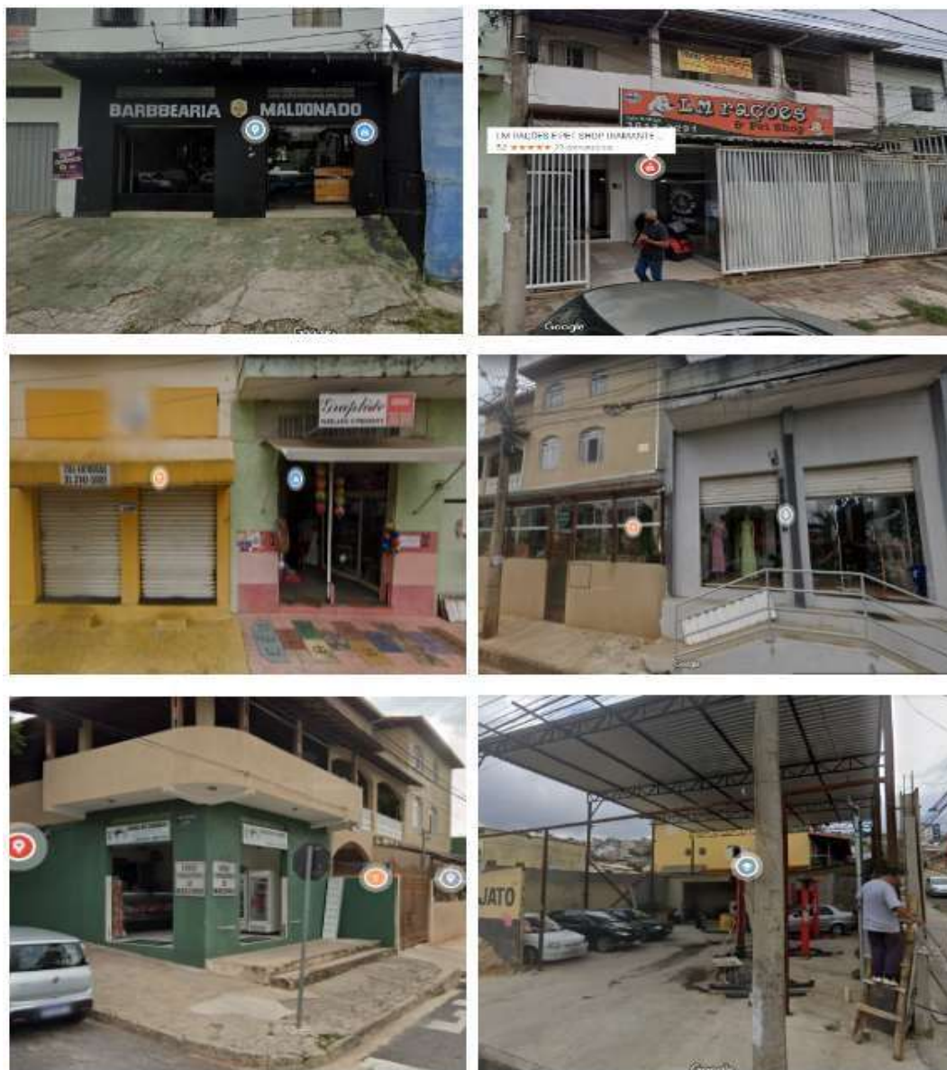
Figura 17: Serviços e Comércio - Rua Alcindo Gonçalves Cotta
